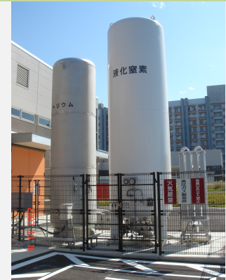
液体窒素貯蔵タンク
