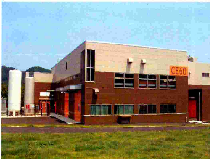
完成した新建屋 CE60（2007.07.24 現在） 左端は 10000L 液化窒素 C E
