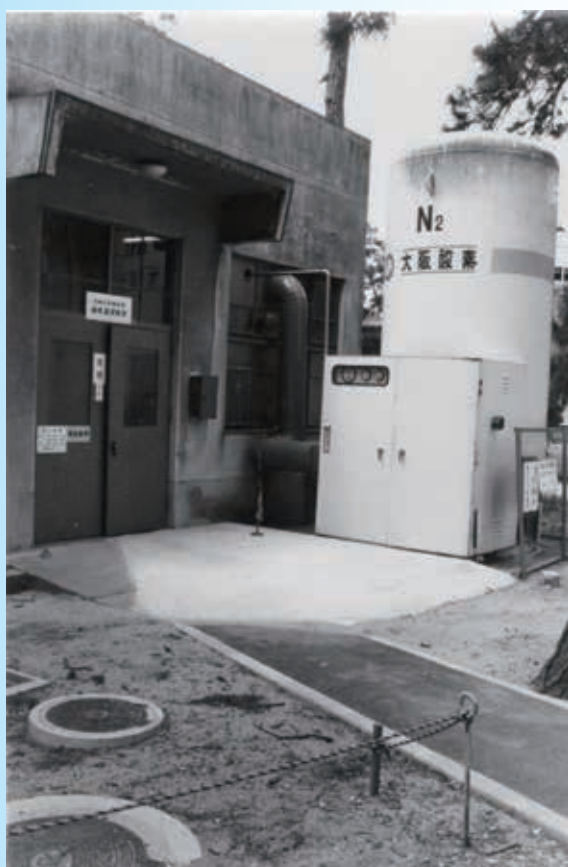
約40年前(1971)の建屋外観
