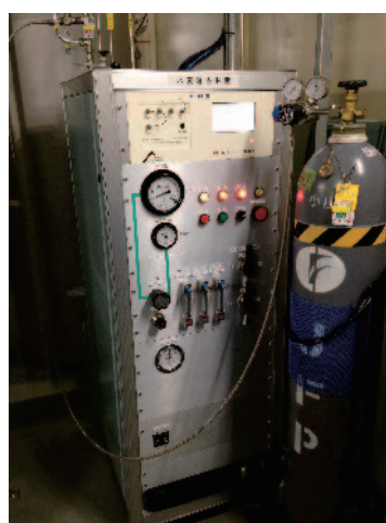
図3 水素除去装置外観
