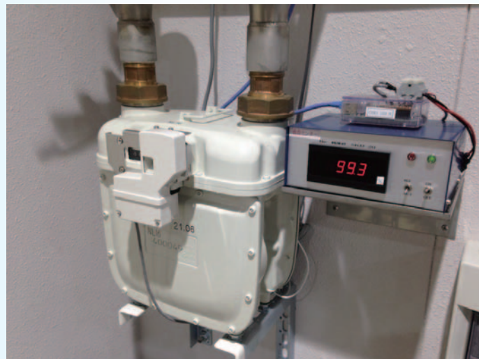
ヘリウム回収状況監視システム
