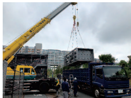
ガスカートドル更新の様子
